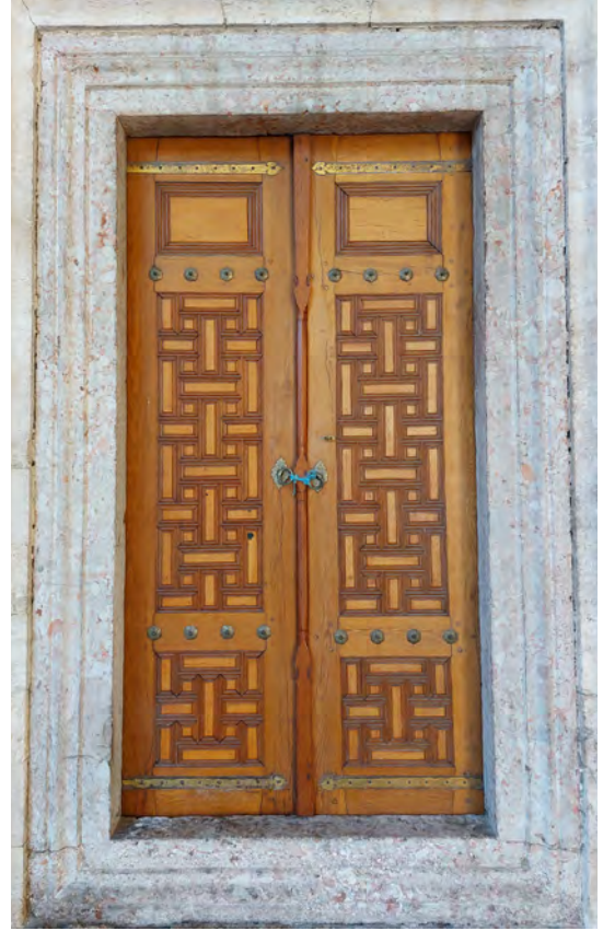
G.2.10. Düz kündekâri tekniki ile yapılmış kapı kanatları, Şehzade Camisi.
